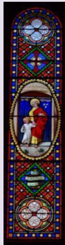
Absidiole sud probablement endommagée par une torche d'éclairage, la coquille a été refaite en plâtre ce qui lui donne un aspect lisse (photo Internet du vitrail)
