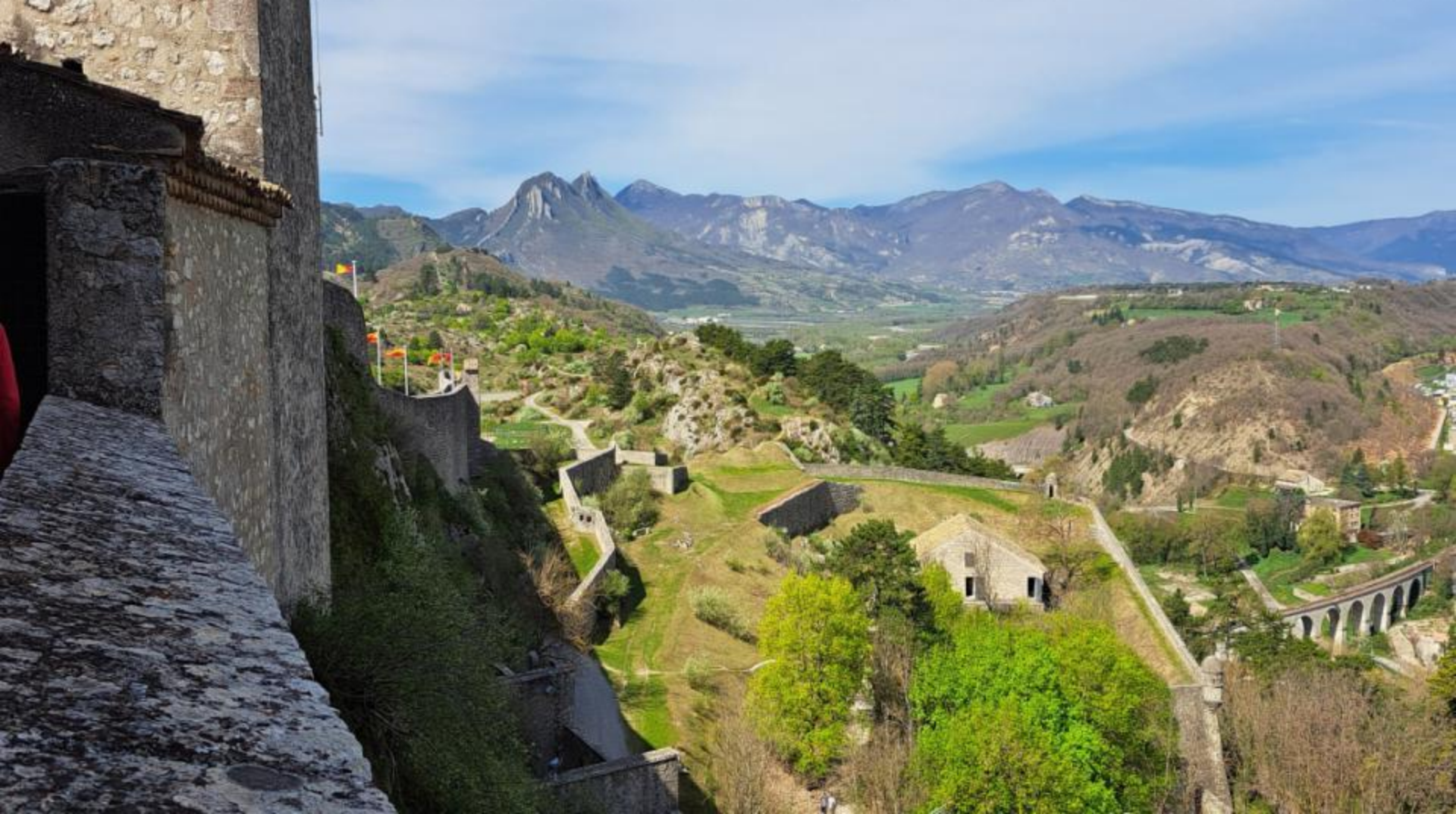
façade nord : Bastion du Buech et poudrière en contrebas
