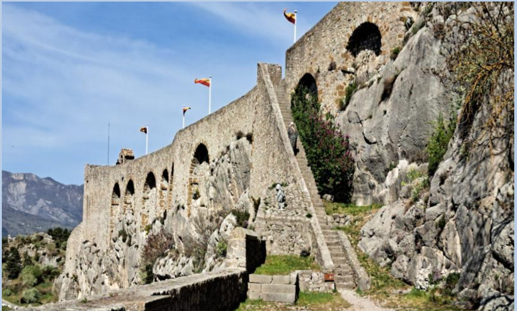
Escalier qui monte au chemin de ronde et au donjon
