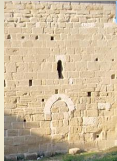
Façade sud avec la porte d'entrée actuelle
