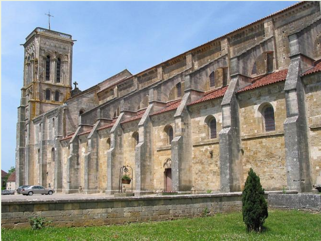
Façade sud de la basilique (photo Internet)
