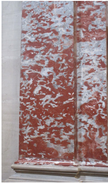
Piliers en marbre rouge
